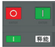
断路器合闸且无储能状态
